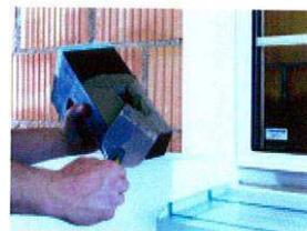
Presionar MTH ELEMENTO DE FIJACIÓN INTERIOR JAMBA Tra-Wik-PH al ras de los paneles aislantes en la sección fresada.
